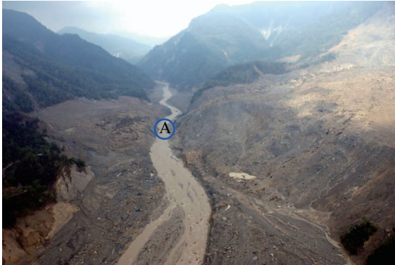
圖 14 小林村空拍影像-原橋址橋位置 (A 點), 崩塌土體堆積嚴重, 為莫拉克颱風期間土體堆積而導致河道阻塞而形成堰塞湖。
