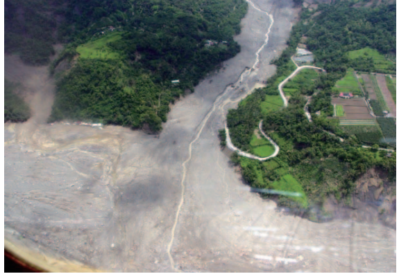
圖9 卦埔溪 (八卦橋) 土石流河道淤積及沖積扇 (2009/9/11 拍攝)
