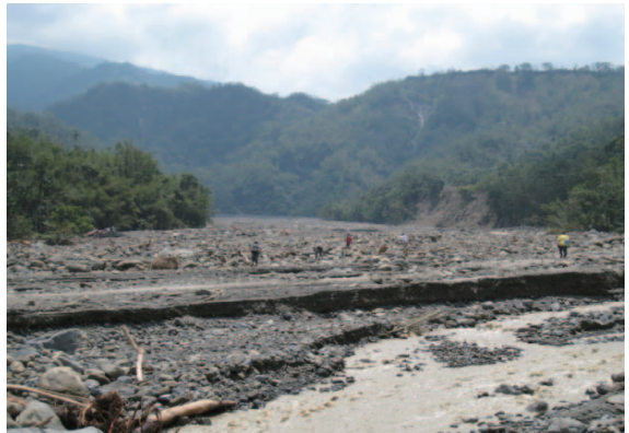
圖10 卦埔溪 (八卦橋) 土石流河道淤積情形 (2009/8/19 拍攝)
