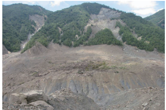
圖 23 小林村原楠峰橋處堆積的大量土石其表面殘存的表土
